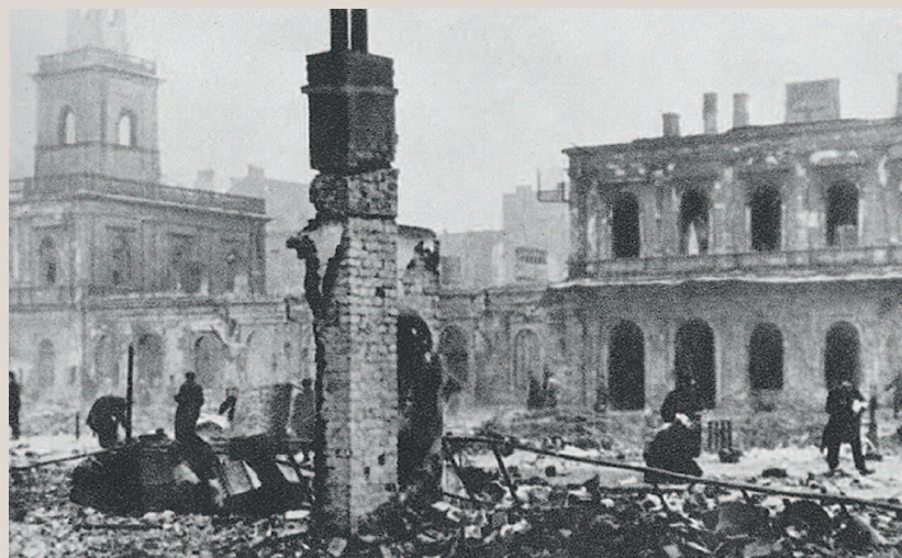
Zniszczony Dworzec Główny w Warszawie, wrzesień 1939 r. FOT. ARCHIWUM
