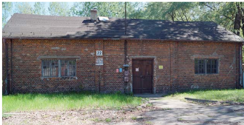
Stolarnia, jeden z trzech budynków infrastruktury obozowej. Praktycznie nie został przekształcony i najbardziej przypomina stan pierwotny. Pozostałe obiekty uległy przebudowie FOT. ARKADIUSZ MINSKA
