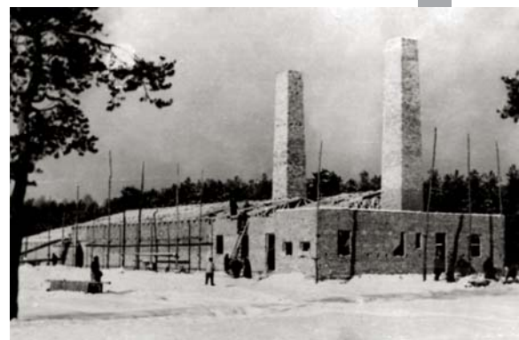
KL Auschwitz II-Birkenau. Krematorium IV w trakcie budowy. Fotografia wykonana w lutym 1943 r. przez SS
