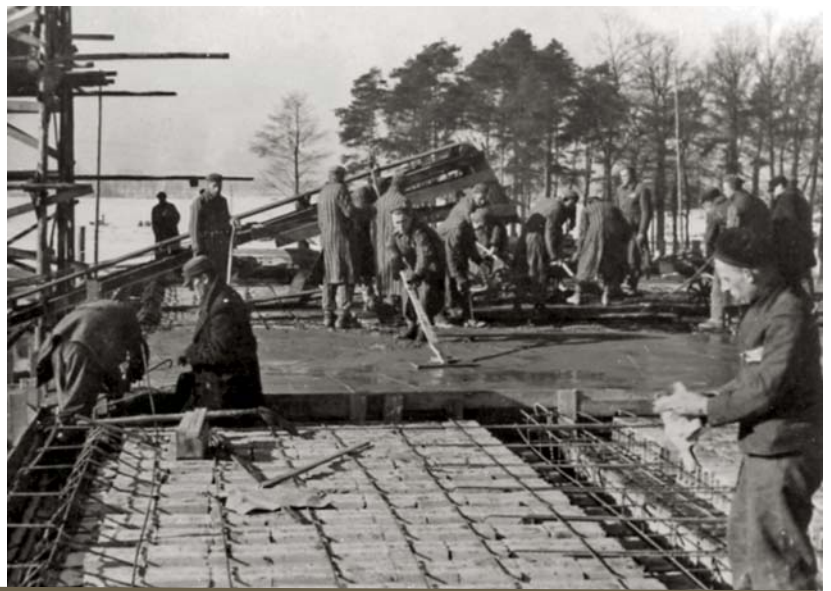
Prace związane z wylewaniem betonu w budynku komory gazowej i krematorium III. Fotografia wykonana przez SS w 1943 r. FOT. ARCHIWUM PAŃSTWOWEGO MUZEUM AUSCHWITZ-BIRKENAU W OŚWIĘCIMIU
