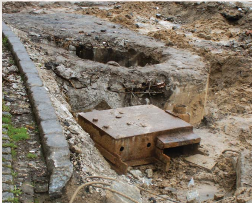
Tobruk odkryty podczas remontu torowiska na pl. Zbawiciela. Widoczny górny otwór strzelca FOT. DOMINIK KAZMIERSKI/UDSKIOR
