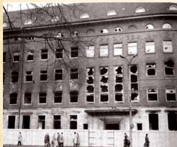
— Gdańsk. Gmach KW PZPR po spaleniu, styczeń 1971 r. ŹRÓDŁO: „GRUDZIEN 1970”, EDITIONS SPOTKANIA, PARYŻ 1986
