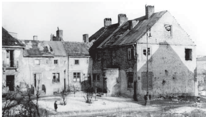
Dom przy ul. Fortecznej 4 z czasu zaraz po wojnie – widok od podwórka FOT. ARCHIWUM AUTORA
